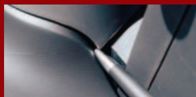
Nie uszczelniono nierównych szczelin
